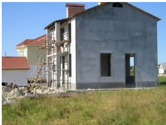
Рис. 1. Жилой двухэтажный дом, возводимый с использованием стеновых газобетонных панелей
