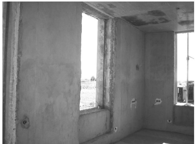
Рис. 2. Фрагмент внутреннего помещения жилого двухэтажного дома возводимого с использованием стеновых газобетонных панелей
